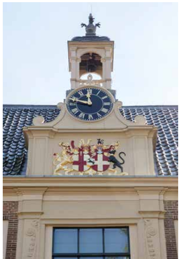
Alliantiewapen, hoofdingang kasteel Ruurlo 11
